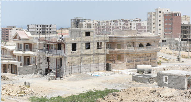
ساخت و ساز در نیکوه مسکونی
