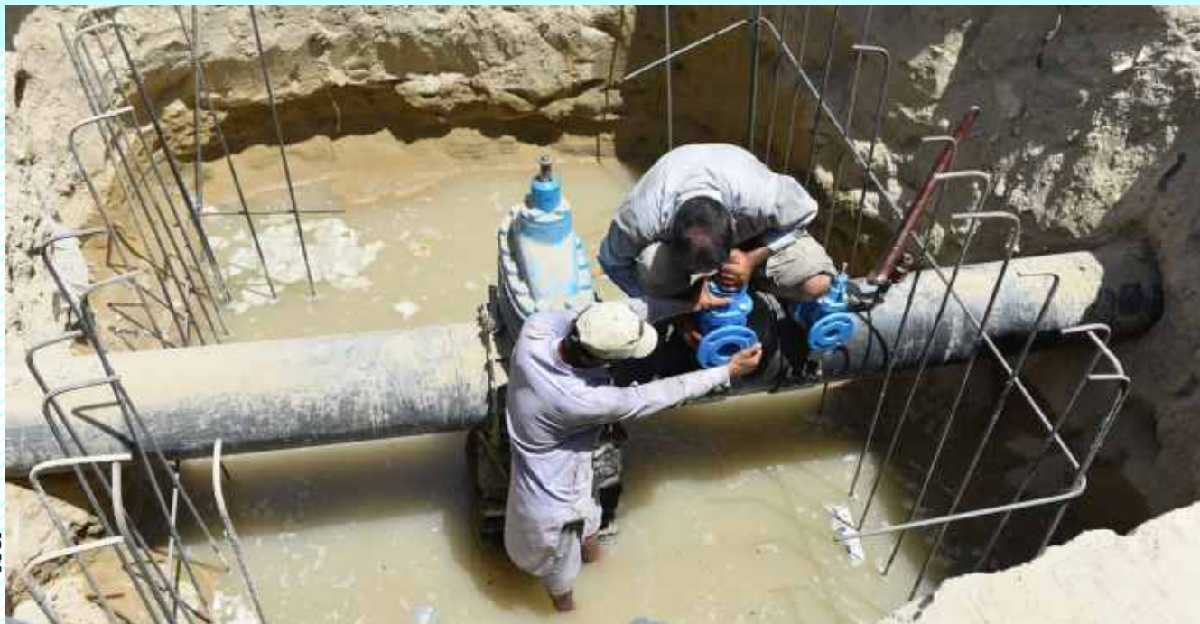
آماده سازی زیرساخت ها
